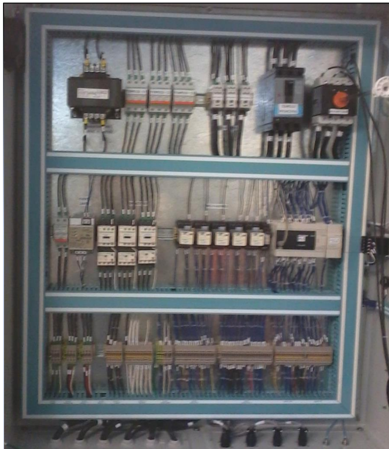
Fig. A. 22. Tablero de control terminado un día antes de la entrega.
